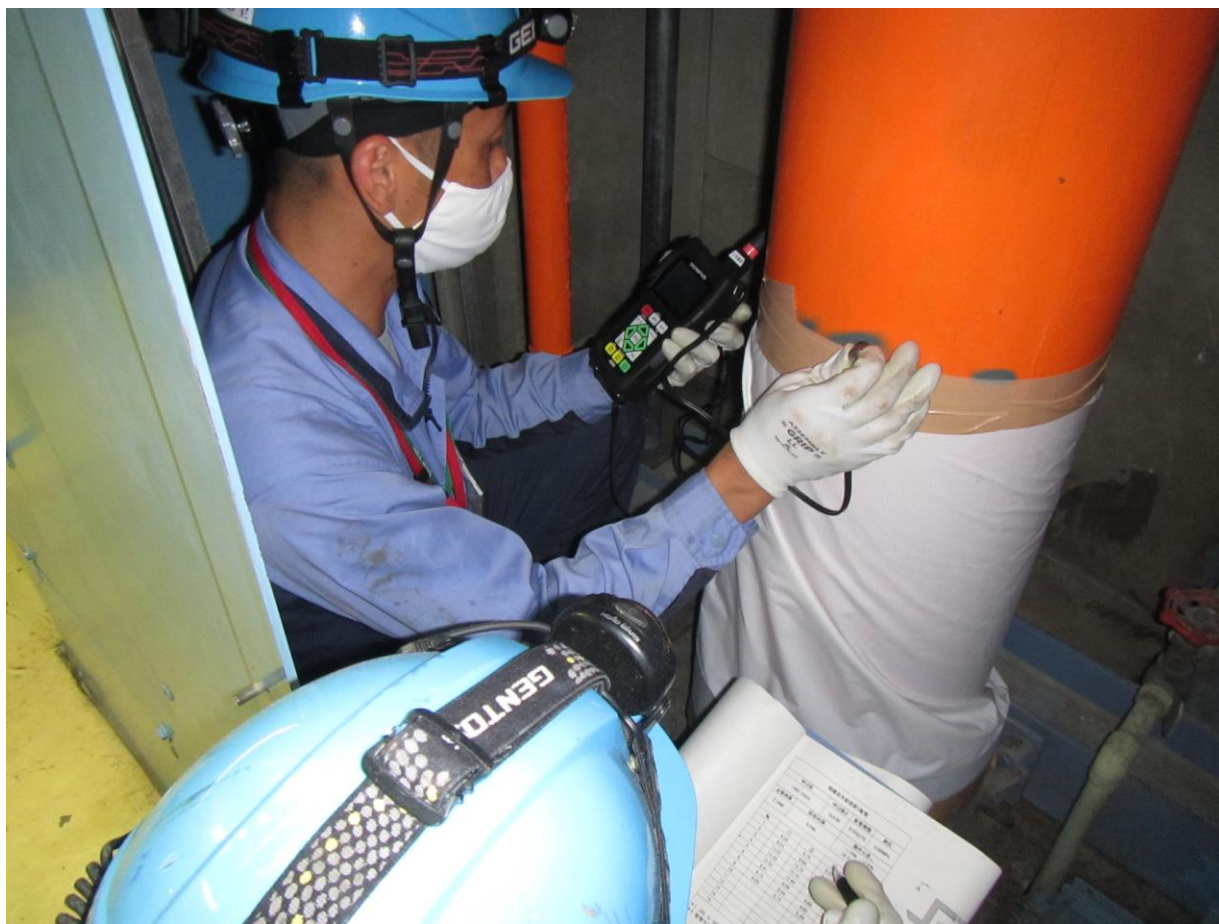
配管の肉厚測定の様子
