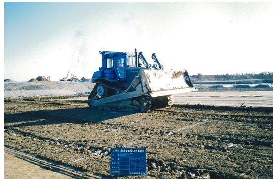
ブルドーザー転圧
