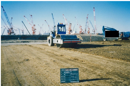
振動ローラー転圧
