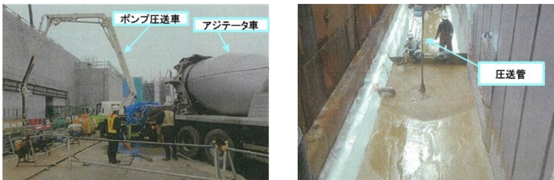
参考 7-2 図(2) 流動化処理土の施工状況
