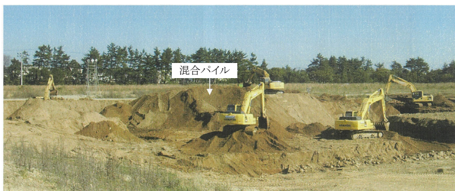
混合・攪拌状況①
