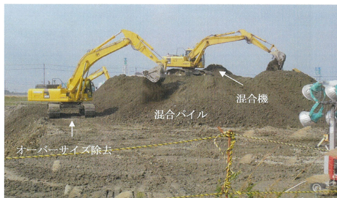
混合・攪拌状況②
