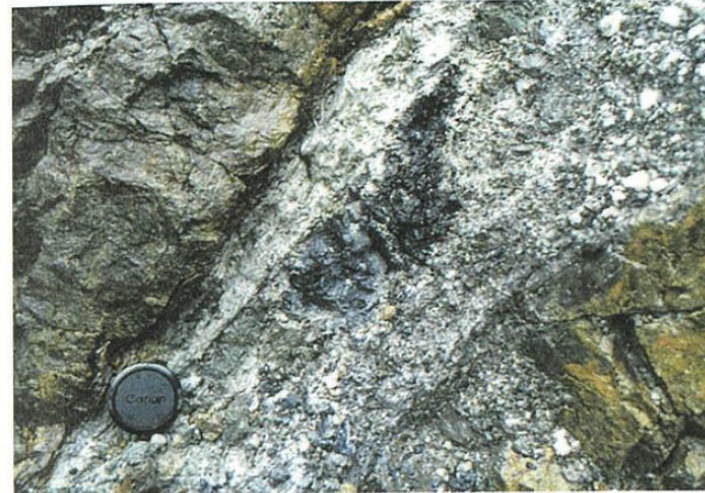
写真-1.13 中・古生代の砂岩中の断層に沿う熱水変質(断層沿いに熱水変質が選択的に進行して白色の粘土鉱物を生じ、掘削による応力開放と地下水の影響によって軟弱化している)
