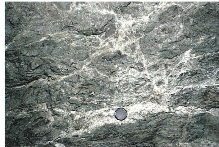
写真-2.7 中・古生代の緑色岩の熱水変質(多数の不規則な節理沿いに熱水変質を受けて網目状に白色の粘土脈が分布しており、強度は粘土脈の分布しない部分に比較して1ランク以上劣る)
