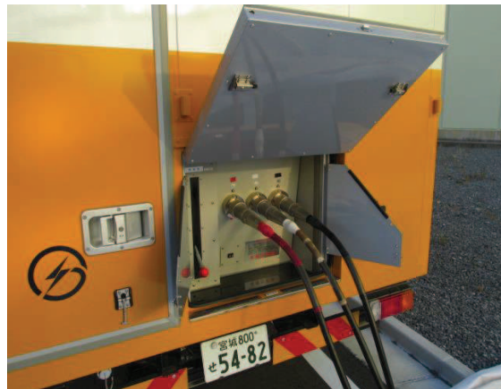
電源車ケーブル接続
