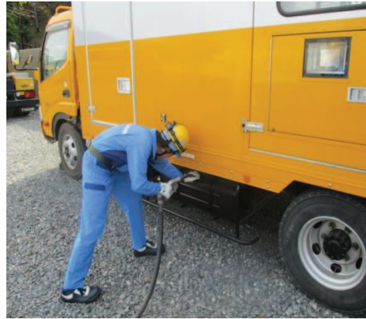
電源車への補給
