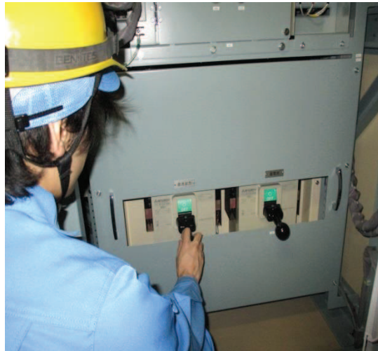
125V 代替蓄電池の切操作
