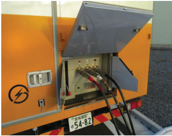
電源車ケーブル接続
