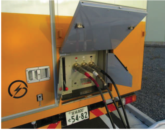
電源車ケーブル接続
