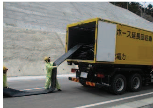
ホース敷設，接続
