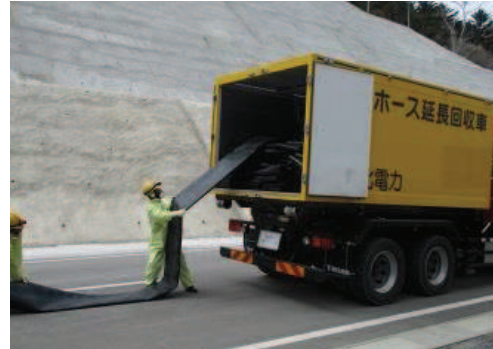
ホースの敷設、接続
