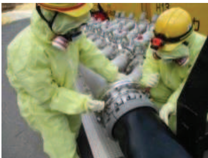
注水用ヘッダへのホース接続
