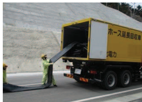
ホース敷設, 接続
