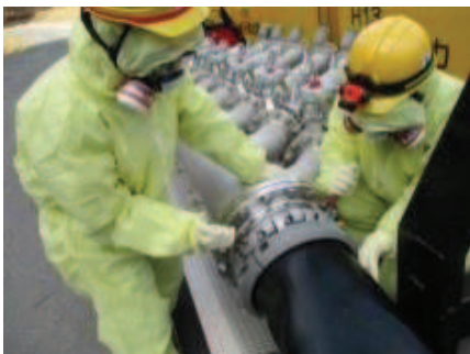
注水用ヘッダへのホース接続
