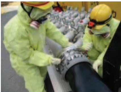
注水用ヘッダへのホース接続
