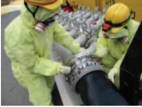
注水用ヘッダへのホース接続
