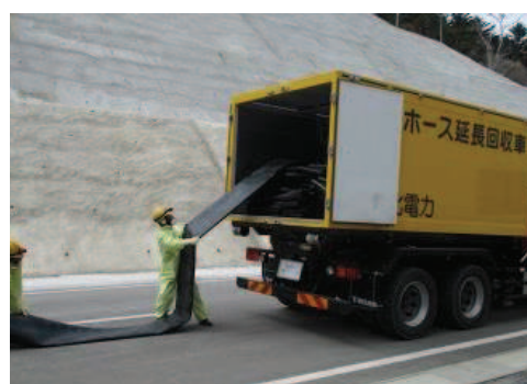
ホース敷設, 接続
