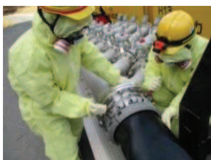
注水用ヘッダへのホース接続
