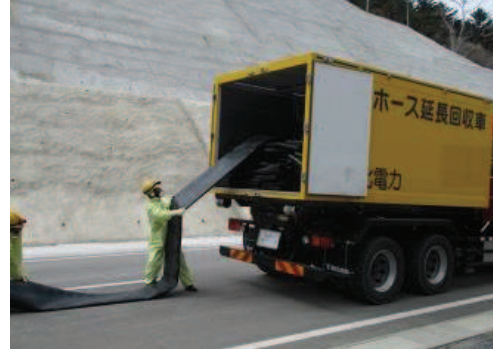
ホースの敷設，接続
