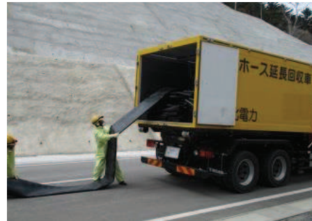
ホースの敷設、接続
