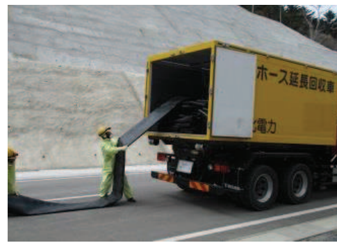
ホース敷設，接続
