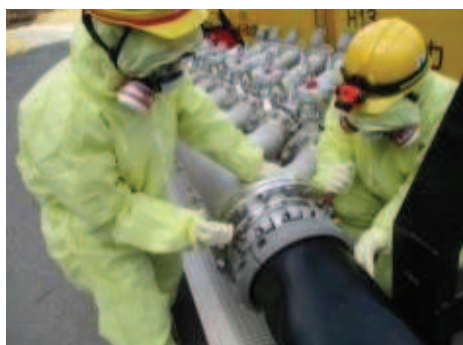
注水用ヘッダへのホース接続
