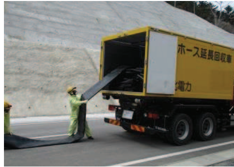
ホース敷設, 接続 (屋外)
