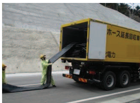
ホース敷設，接続
