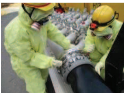
注水用ヘッダへのホース接続
