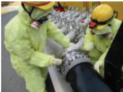
注水用ヘッダへのホース接続
