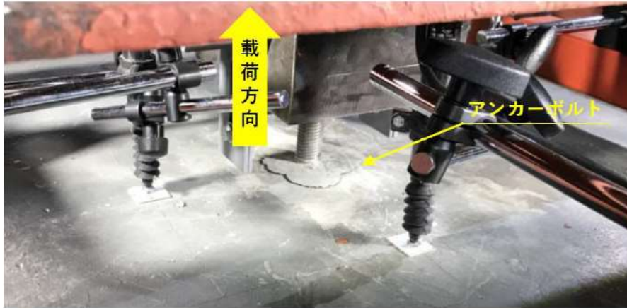
第 7-63 図 引張試験1-4 最大荷重載荷時の状況写真
