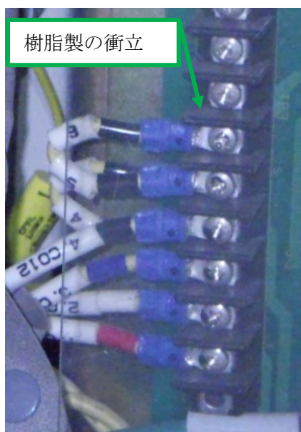
第3図 樹脂製の衝立を設ける設計の例
