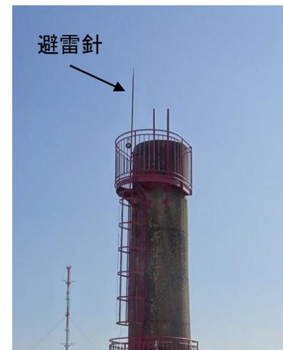
β・γ固体処理棟Ⅲ排気筒 避雷設備
