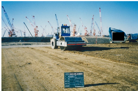
振動ローラー転圧
