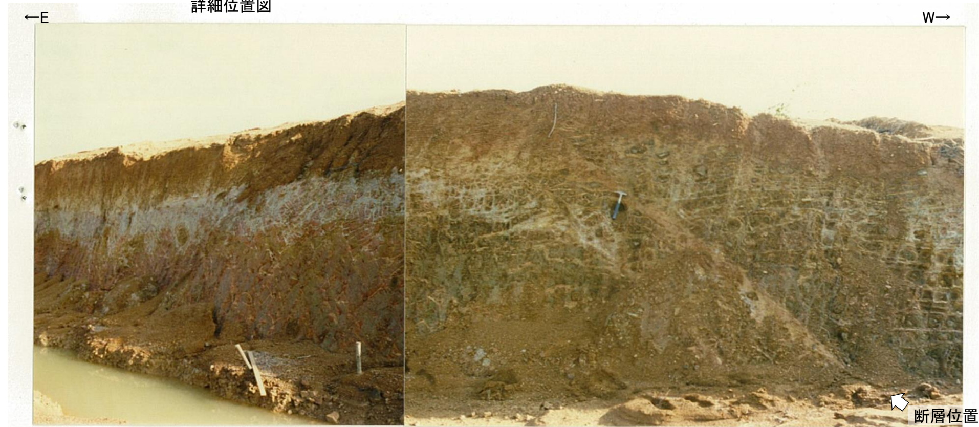
断層露頭写真(1979~1980年撮影) (半の浦西リニアメントから約100m東方)
