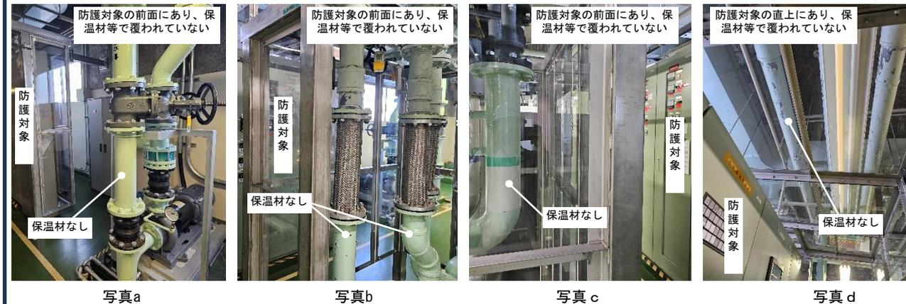
被水の影響がないと評価した配管の一例
