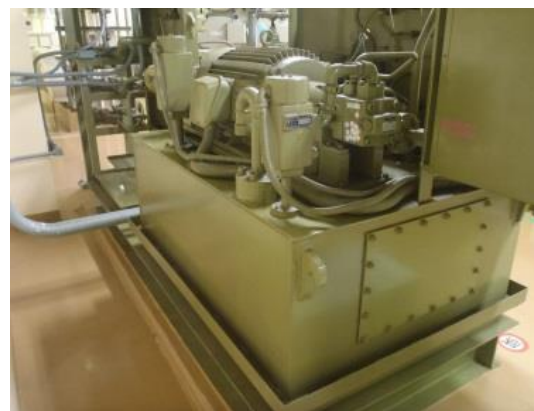
オイルパンの設置
