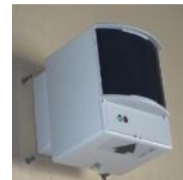
煙感知器 (光電式分離型)
