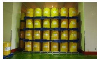
200ℓドラム缶 (例) 解体分別保管棟
