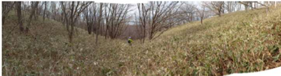
P1 防災科研調査において側方崖とされる斜面の状況 沢を挟んだ両岸において、斜面の角度が同程度となっており、側方崖を示唆する特徴である。地滑り土塊とされる箇所に向かう明瞭な急傾斜は認められない。
