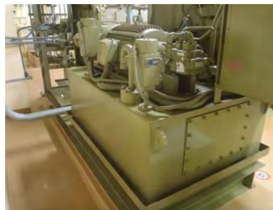
オイルパンの設置
