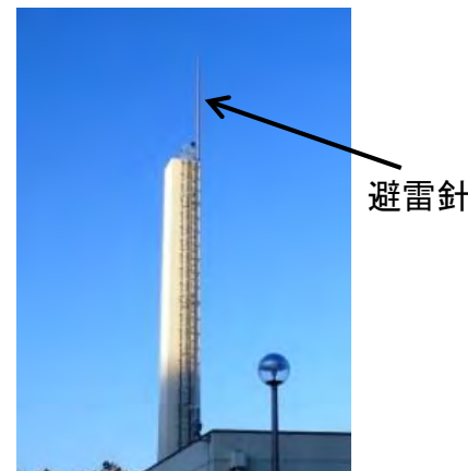
避雷針の設置 (例) 第1廃棄物処理棟(排気筒)
