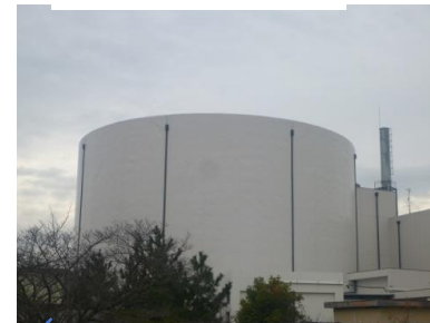
原子炉格納施設外観
