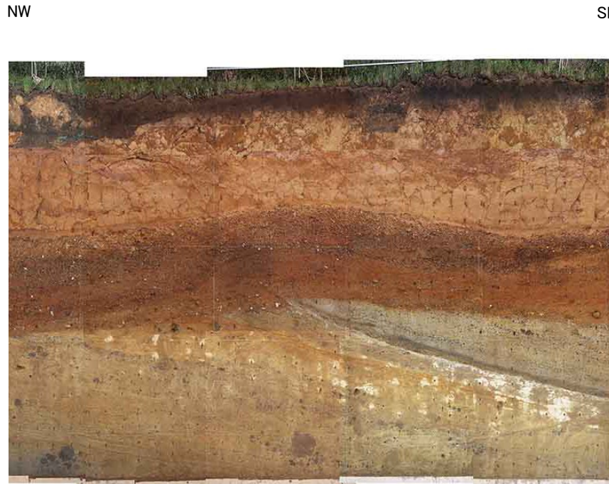
図(4.3) 法面写真(Ts-6法面)
