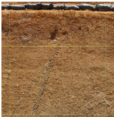
図(2.4) 南側法面詳細写真(解釈線なし)
