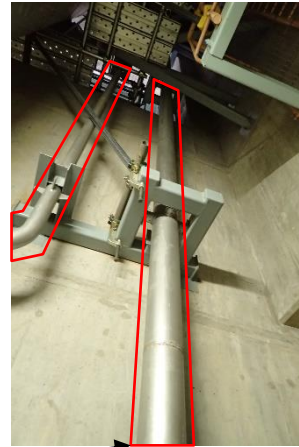
R/B 敷設状況
