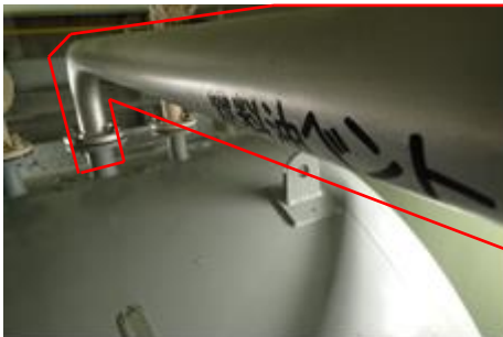
ディーゼル燃料デイトンク周辺敷設状況
