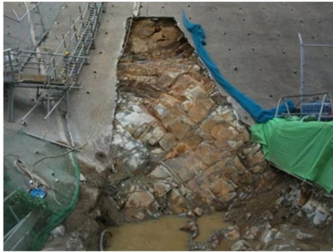
图 1.2-10 防波壁東端部 岩盤露出狀況
