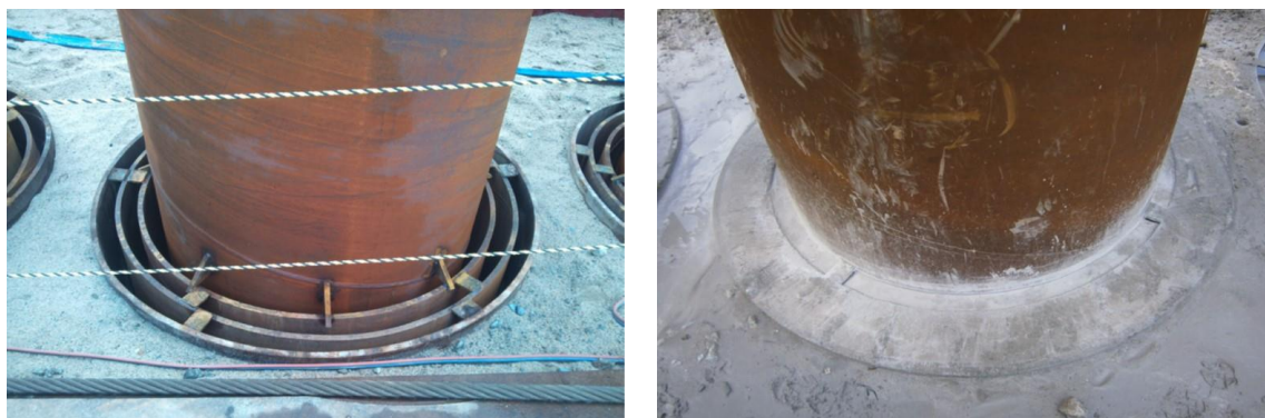
図 2.2-11 モルタル（充填材）の施工状況（左側：施工前，右側：施工後）
