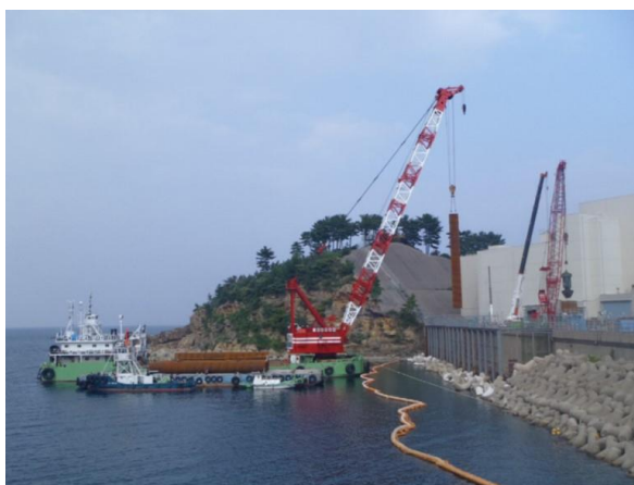
図 2.2-8 鋼管杭（最外管）の建て込み状況
