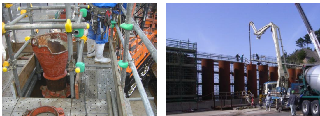
図 2.2-12 中詰コンクリートの施工状況 （左側：トレミー管設置状況，右側：中詰コンクリート打設状況）
