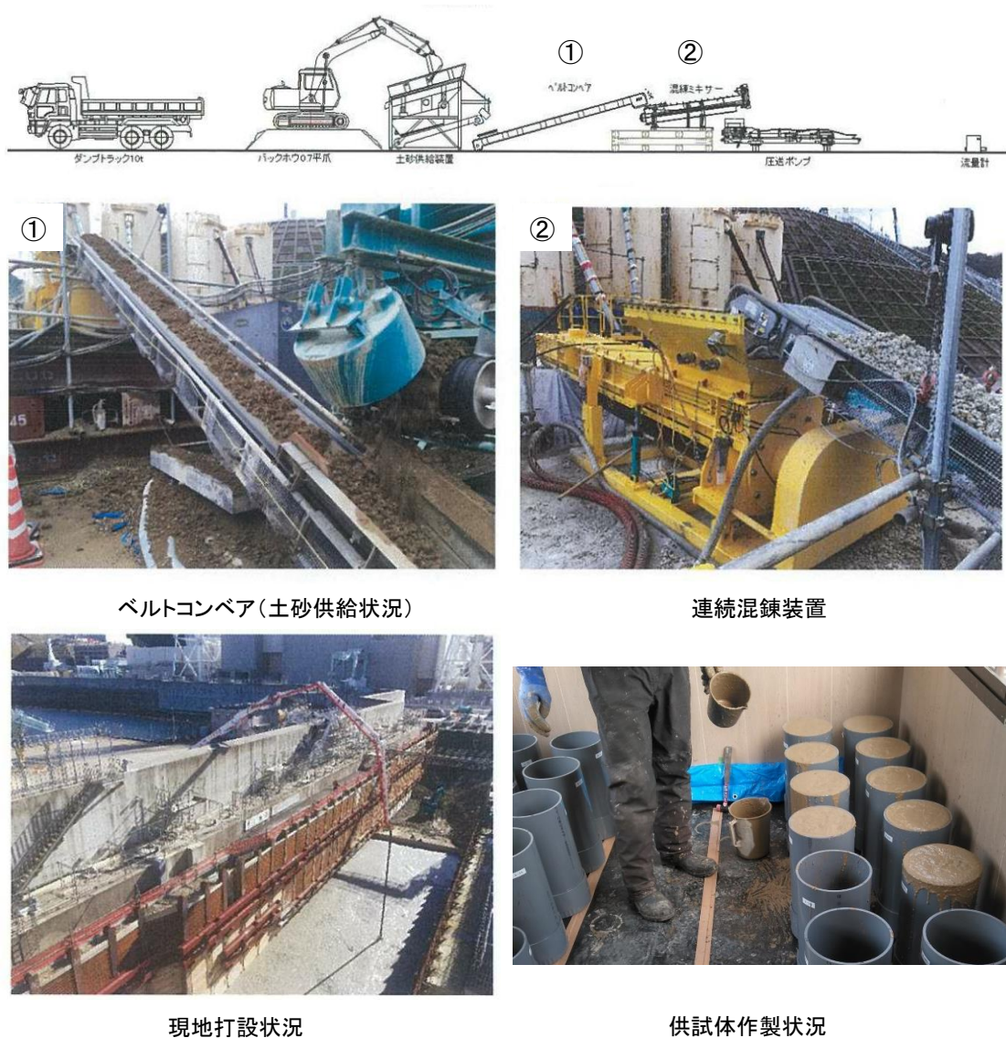
図 4.8.2-2 流動化処理土製造・打設・供試体作製状況
