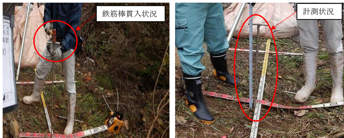
図 2-16 確認試験実施状況写真
