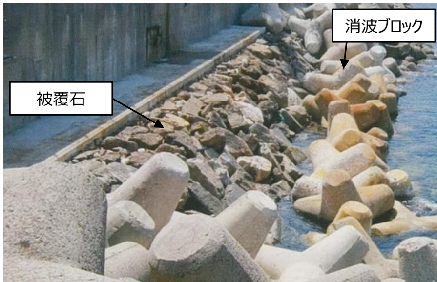
被覆石の設置状況（1，2号機北側護岸）
