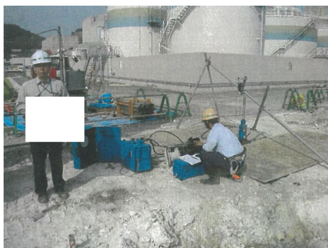
図 7-2 引抜き試験実施状況写真（2011 年実施）
