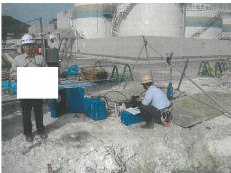
図 3-7 引抜き試験実施状況写真 (2011 年実施)
