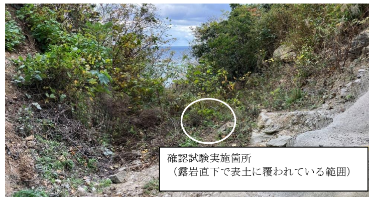
図 2-14 確認試験実施箇所拡大写真
