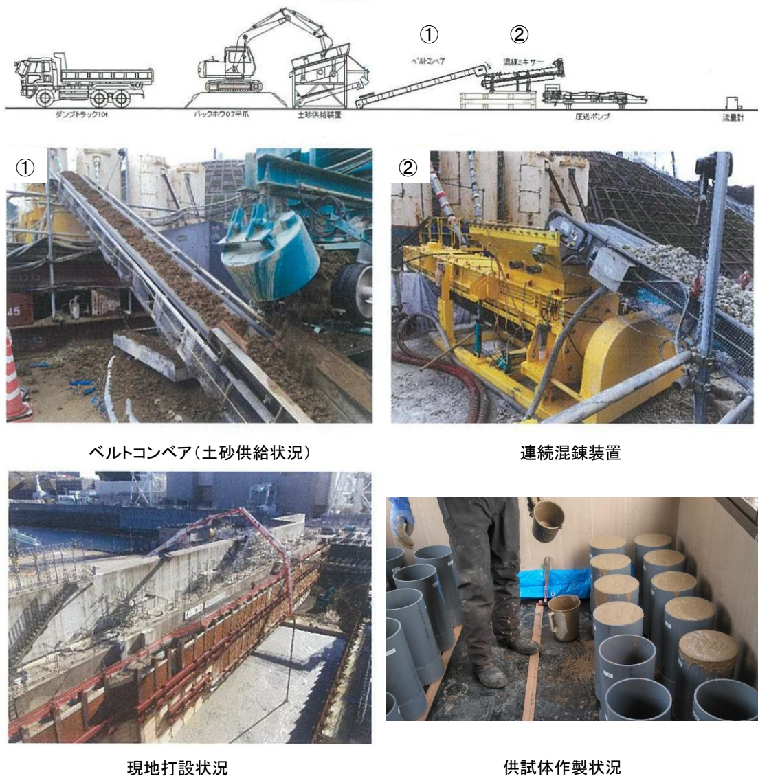
図 4.8.2-2 流動化処理土製造・打設・供試体作製状況
