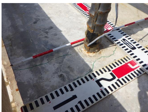
(a) 「浮き」除去前
