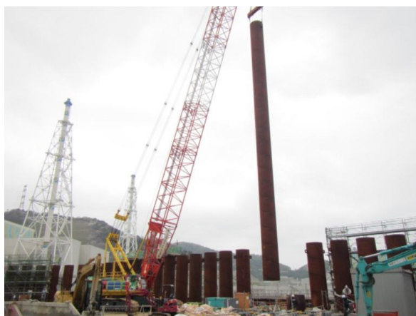
図 2.2-10 鋼管杭（中杭）の建て込み状況
