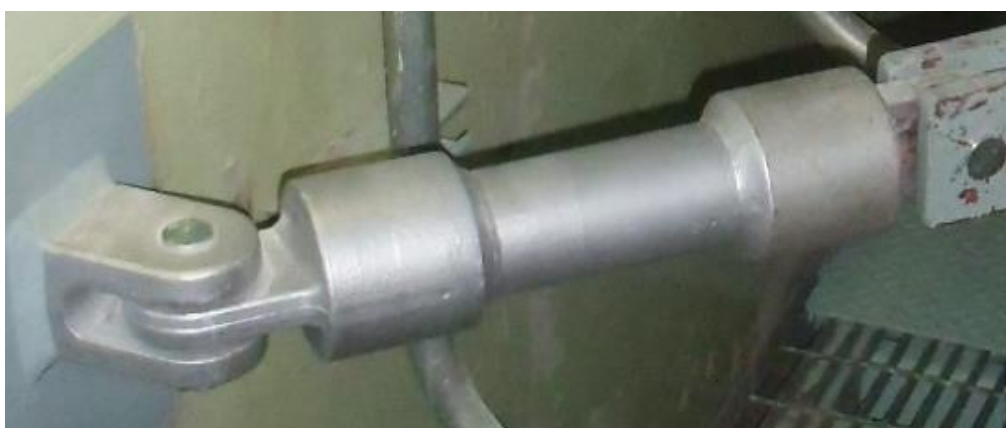
図 3-14 RTS 型ロッドレストレイントの外観
