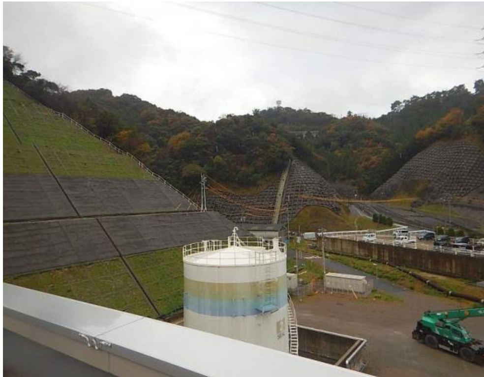
(例) 構内監視カメラ (ガスタービン発電機建物屋上) にて 輪谷貯水槽 (西 1 / 西 2) の南側方向
