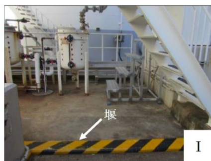
図4-2 堰周りの状況（排水中和用塩酸タンク）
