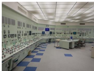
非常用照明点灯時
