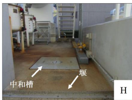
図4-2 堰周りの状況（排水中和用塩酸タンク）
