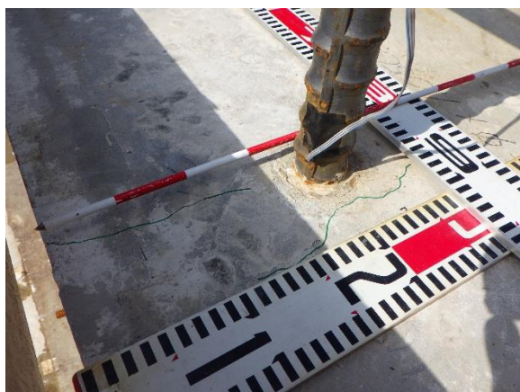
(a) 「浮き」除去前
