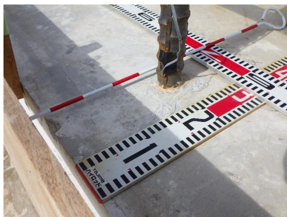
(b) 「浮き」除去後
