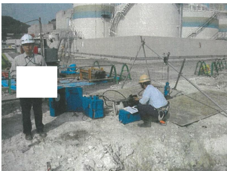
図 3-7 引抜き試験実施状況写真 (2011 年実施)
