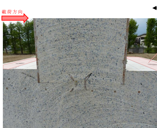
図 2.3.2-5 杭頭内部のひび割れ状況
