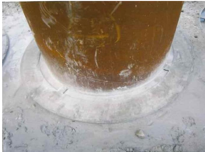
多重鋼管杭建込み状況 (モルタル(充填材)打設後) 図 1-3(2) 杭頭部の状況
