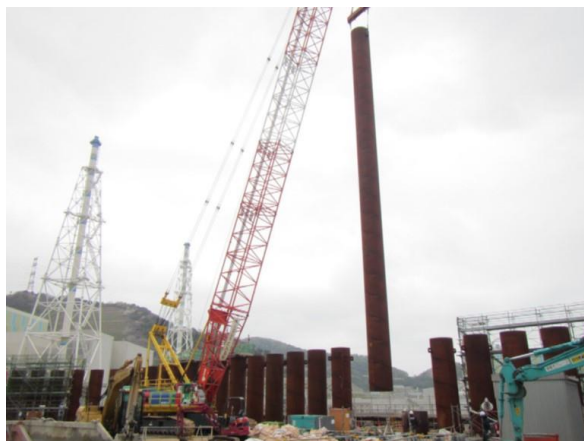
図 2.2-10 鋼管杭（中杭）の建て込み状況
