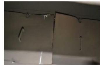
盤内仕切板の状態 (母線室-遮断器室間)
