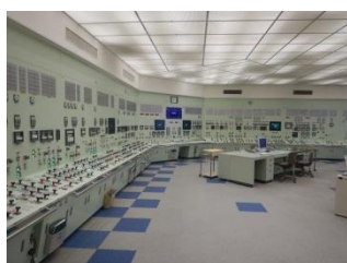
非常用照明点灯時
