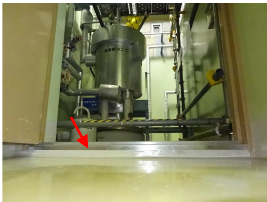
図 4-1 漏えい油の拡大の防止対策の例
