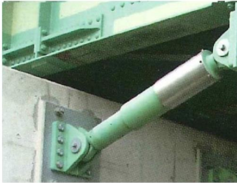
単軸粘性ダンパの外観（橋梁への設置例）
