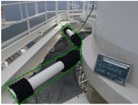
図 5-1 島根 2 号機の排気筒に設置した単軸粘性ダンパの外観及び構造
