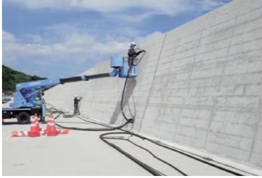
1. 既設部分の目荒らし
