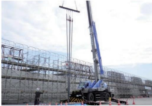
3. 新設部分の主筋建込み
