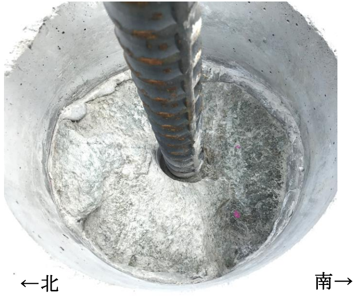
図 4-7 岩盤定着状況 (No. D51-1)
