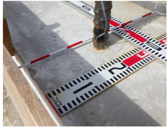
(b) 「浮き」除去後
