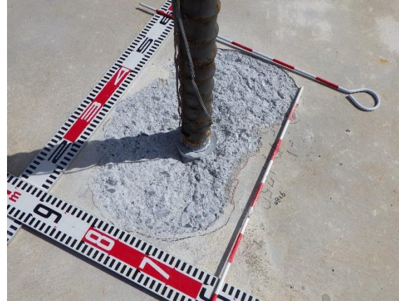
(b) 「浮き」除去後
