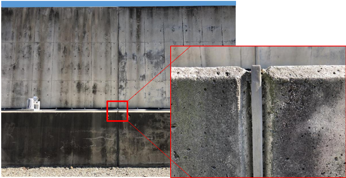
図 2.2-5 目地材写真（樹脂発泡体目地材，厚さ 20mm）
