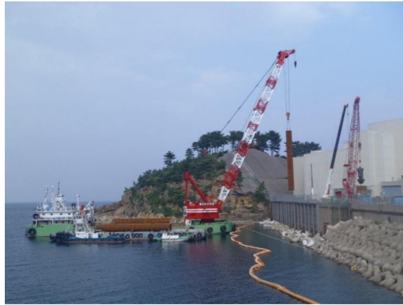
図 2.2-8 鋼管杭（最外管）の建て込み状況
