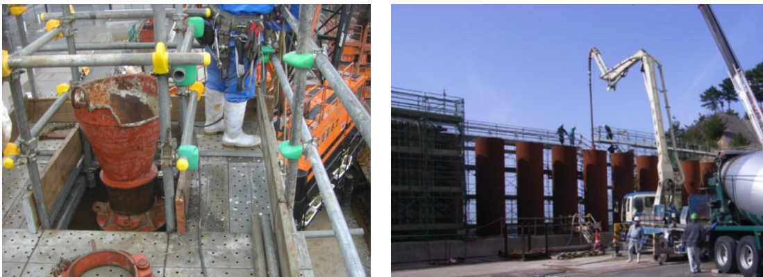
図 2.2-12 中詰コンクリートの施工状況
