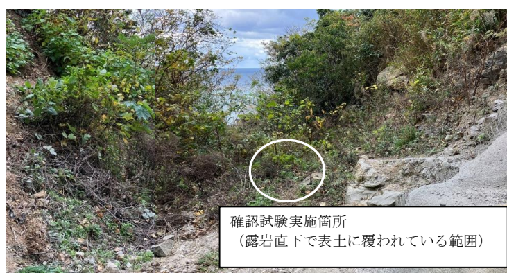
図 2-14 確認試験実施箇所拡大写真
