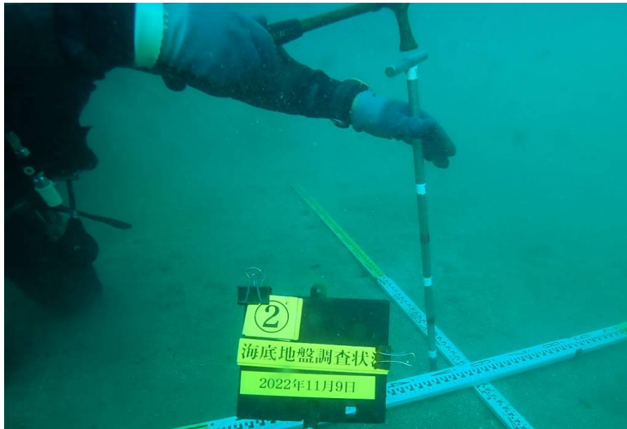
図 2-12 鉄筋棒貫入状況 (ハンマー使用)
