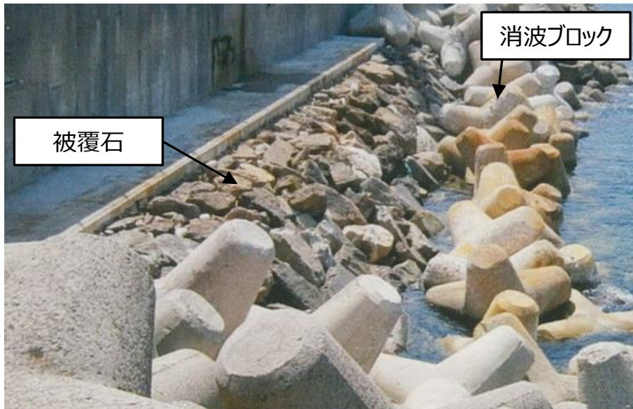
被覆石の設置状況（1，2号機北側護岸）
