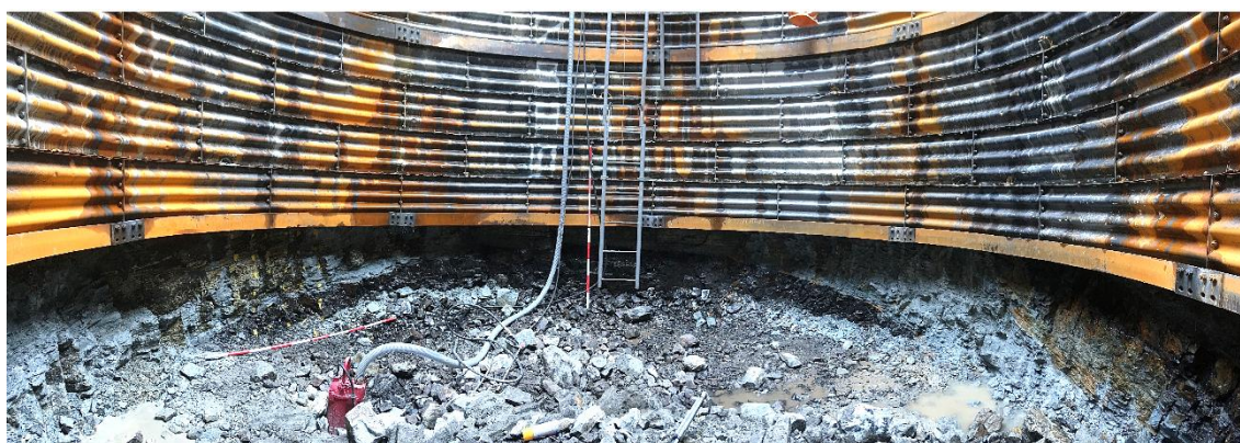
図 2.7.2-30 島根サイトの深礎杭 掘削面の写真 (南側)
