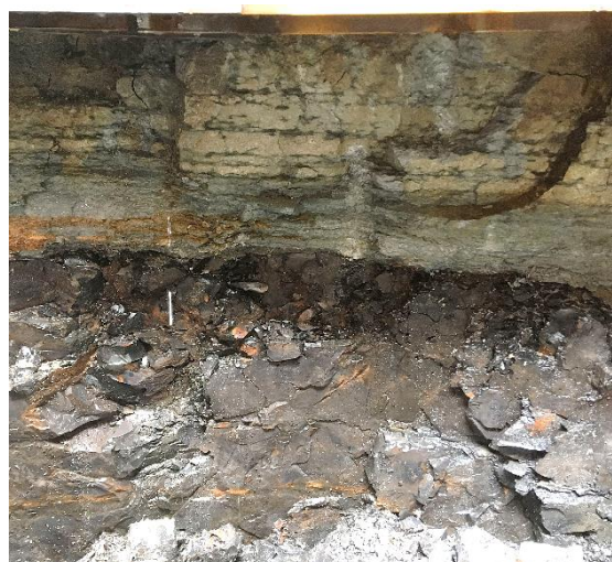
図 2.7.2-32 掘削面の近接写真
