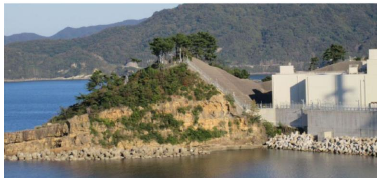
図 1.2-14 防波壁（東端部）地山状況
