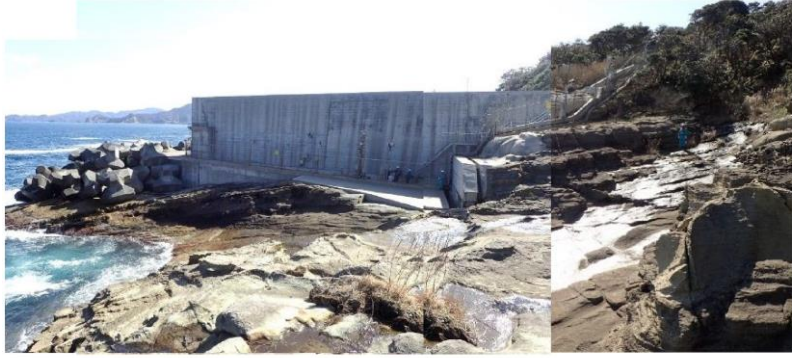
図 1.2-15 防波壁（西端部）地山状況
