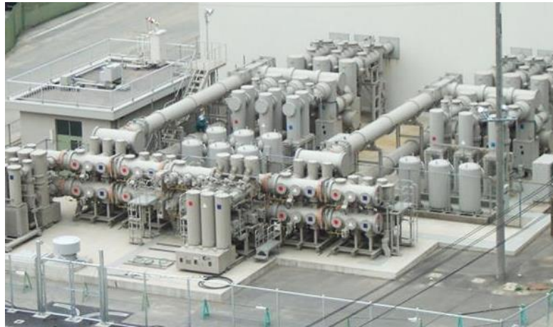
(ガス絶縁開閉装置イメージ)
