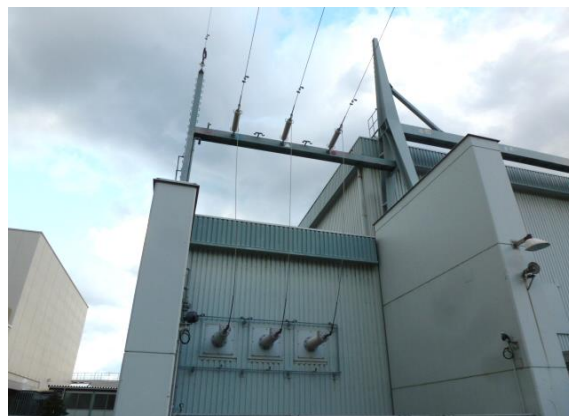
(66kV 開閉所 送電線引込部イメージ)
