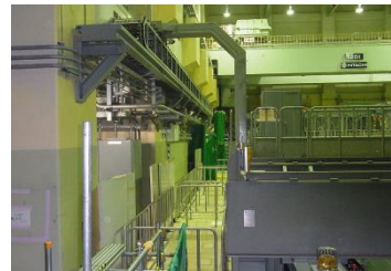
原子炉建物壁面
