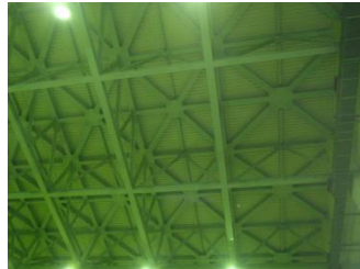
原子炉建物天井
