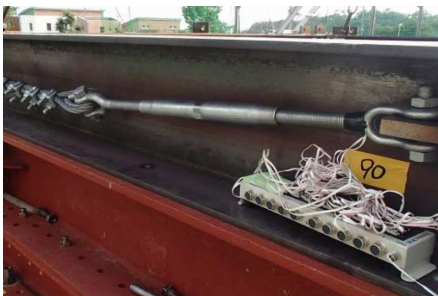
図3-1 ひずみゲージ付きターンバックルの設置状況
