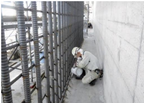
5. 主筋定着部の固定
