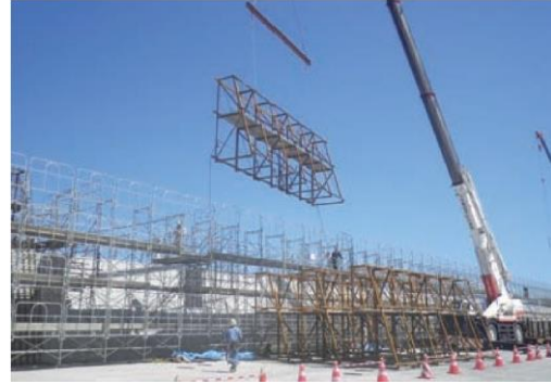
2. 鉄筋架台の設置
