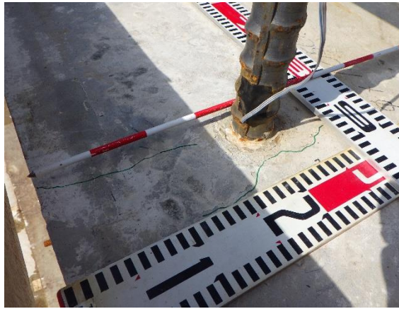
(a) 「浮き」除去前
