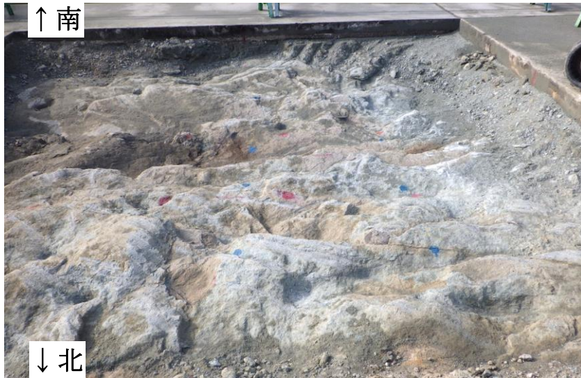
图 4-5 岩盤露出狀況（凝灰岩（ C_H 級））
