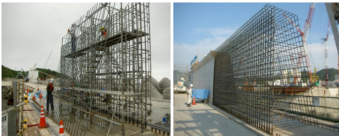
1. 既設部分の主筋組立
