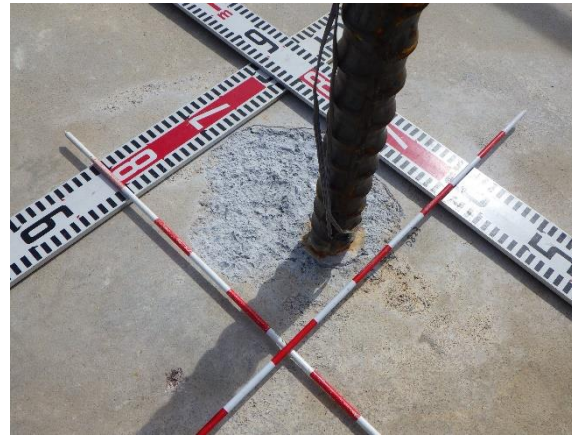
(b) 「浮き」除去後
