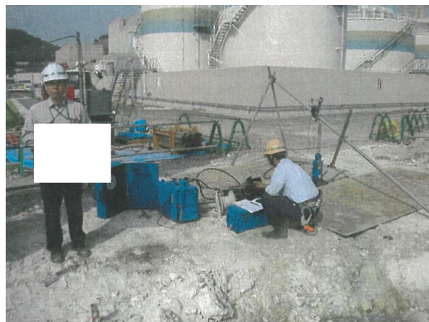
図7-2 引抜き試験実施状況写真（2011年実施）
