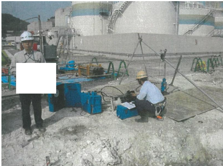
図 3-7 引抜き試験実施状況写真 (2011 年実施)
