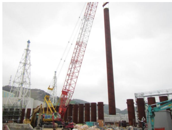
図 2.2-10 鋼管杭（中杭）の建て込み状況
