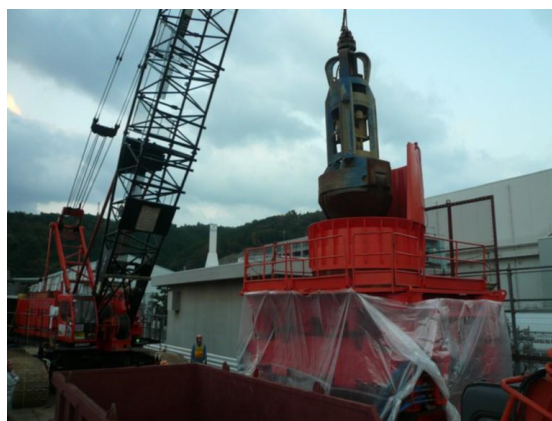
図 2.2-7 オールケーシング工法による掘削状況
