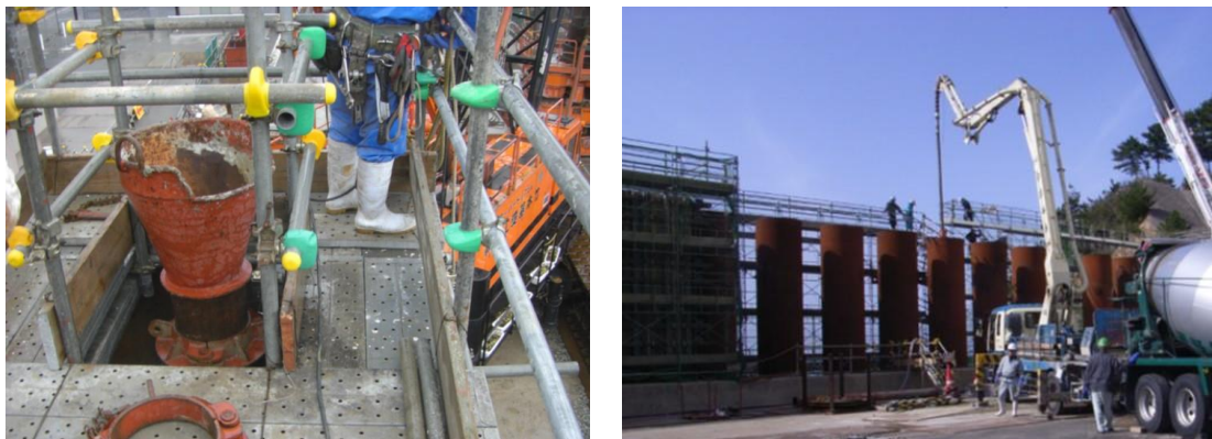
図 2.2-12 中詰コンクリートの施工状況
