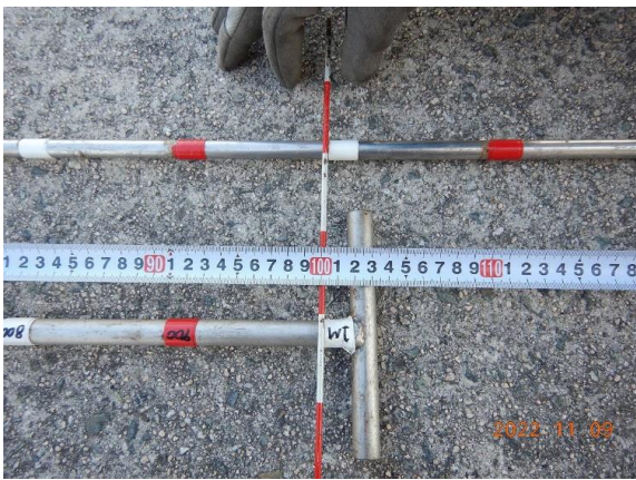
(c) 使用鉄筋棒延長確認
