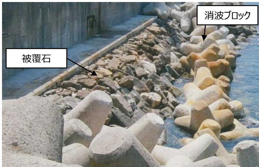
被覆石の設置状況（1，2号機北側護岸）
